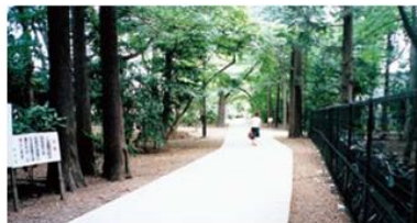
写真1. 井の頭公園園路舗装 (エコセメント利用)
