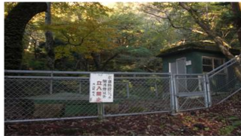
図2 老朽化した簡易水道施設
